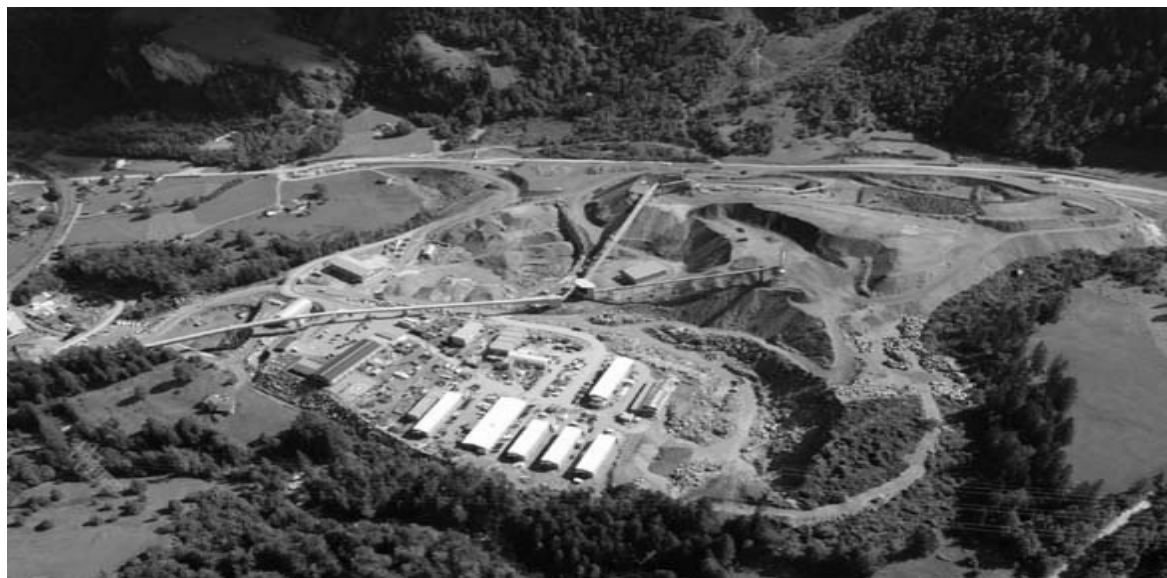
(Cantieri del Lotschberg)
