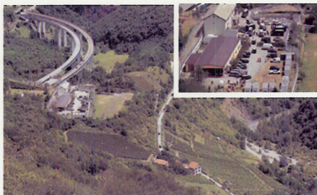
Panoramica e dettaglio dell'avamposto militare "off limits" della Maddalena di Chiomonte
