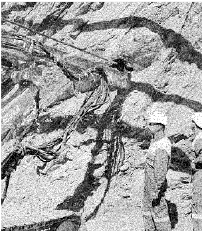
Le operazioni di carotaggio nel versante francese
